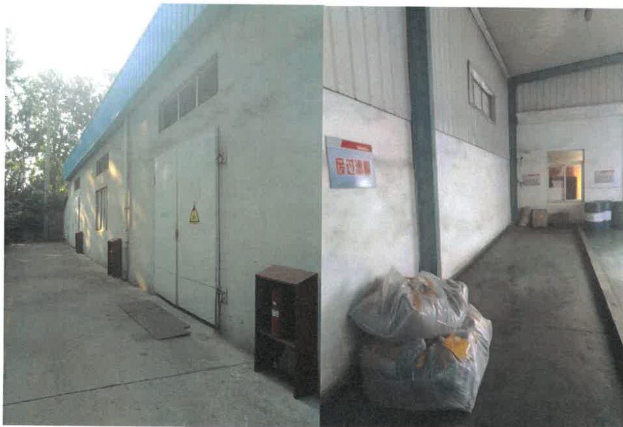
图 9-1 危险废物贮存场所
